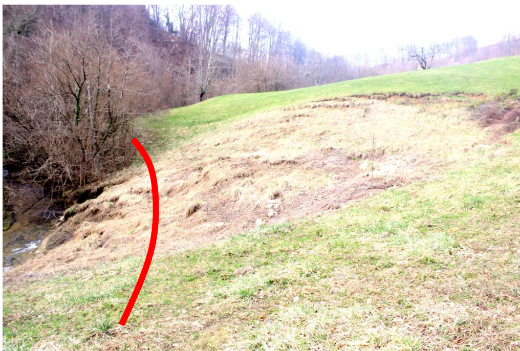
Fotografija 1. Pogled v pobočje na plaz pod cesto, kateri je že delno zdrsnil v potok Buča s shematskim vrisom lokacije zidu
